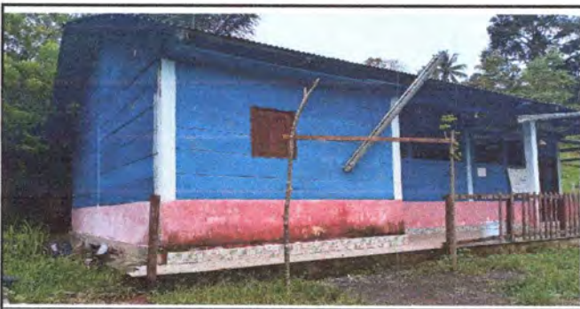
Foto 5: Se reforzara con soleras y columnas de cemento.
