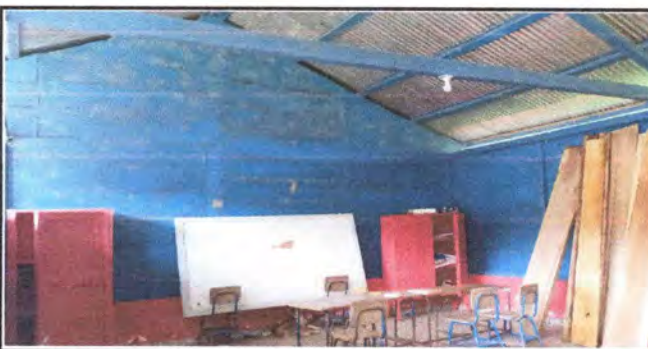
Foto 6: El cambio de paredes de madera a block se realizara para mejorar las condiciones del edificio donde se imparten las clases a los niños.
