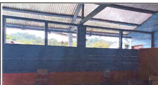
Foto 4: Sustitución de paredes de madera por paredes de block
