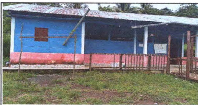
Foto 3: Sustitución de cubierta de lamina este a causa del deterioro provocado por el paso de los años.
