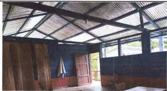
Foto1: Desmontaje de madera por estructura de metal .
